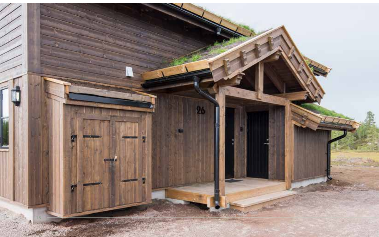
Extra WC i Fjellrypa, detta är standard i Lirypa L och Tiur.
